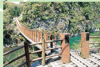
吊橋「火の国橋」
